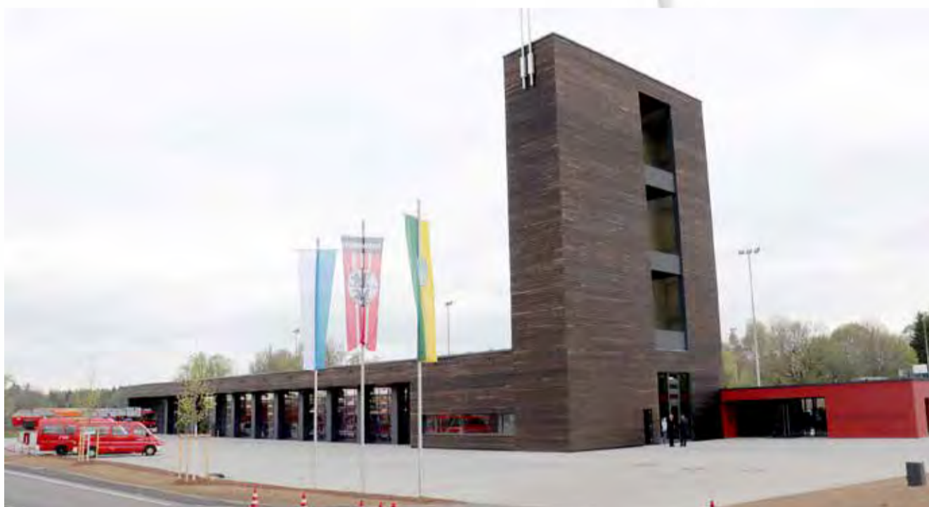
Beeindruckend: Das neue Feuerwehrgerätehaus mit seinem 30 m hohen Übungsturm
