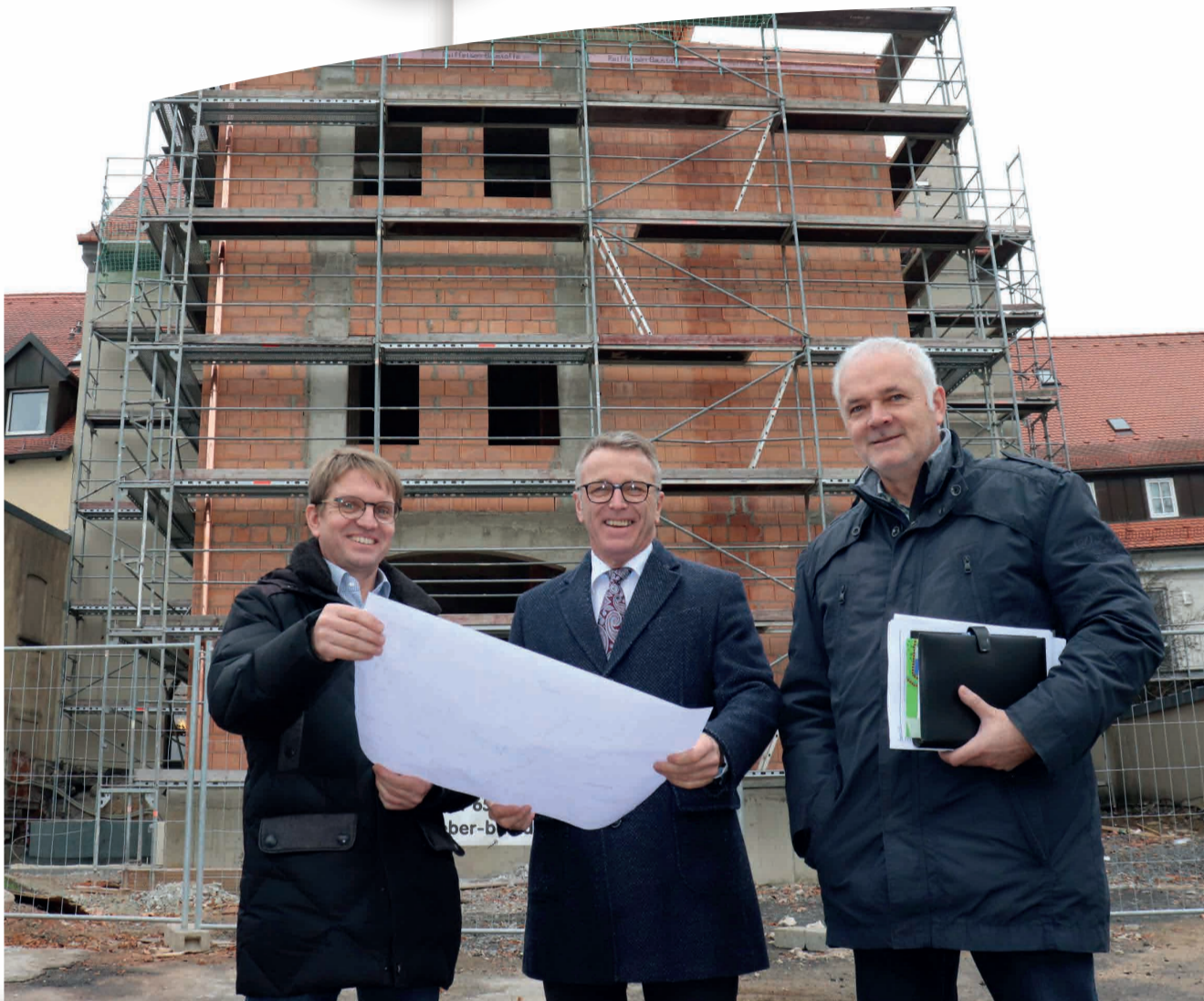
Sie nehmen den Fortschritt der Baumaßnahmen am Rathaus-Anbau regelmäßig in Augenschein: Bürgermeister Franz Stahl (M.), Stadtkämmerer August Trißl (r.) und Stadtbaumeister Andreas Ockl (l.). Der Rohbau steht nun bereits, in den kommenden Wochen erfolgt noch der Innenausbau. Nach der geplanten Fertigstellung im Frühjahr 2019 verfügt der neue Gebäudeteil dann über eine Fluchttreppe, Sanitärebereiche und einen Fahrstuhl. Damit ist künftig ein barrierefreier Zugang zu allen Etagen möglich. Foto: Stadt Tirschenreuth
