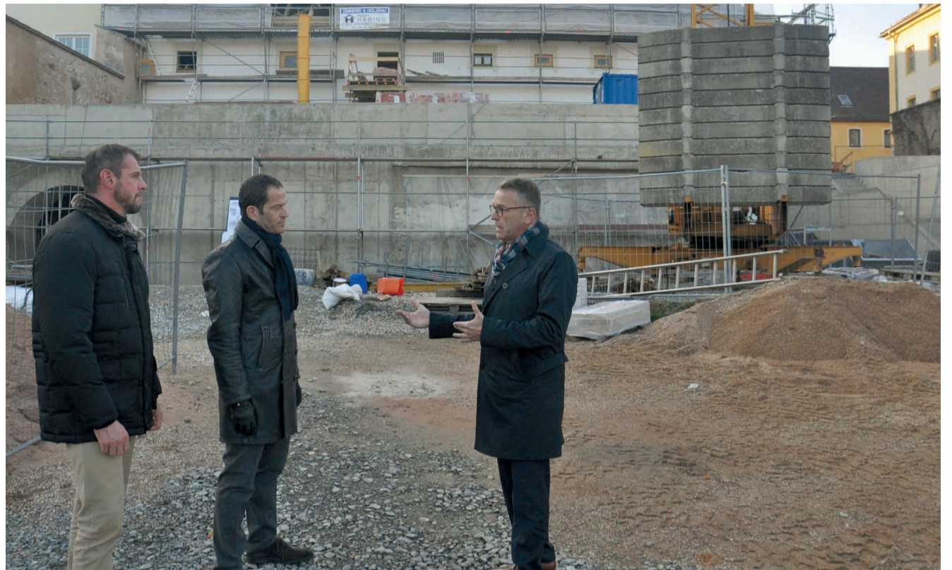
Lobte Tirschenreuth als „Vorbild für erfolgreichen Stadtumbau“: Bundestagsabgeordneter Albert Rupprecht (M.), hier mit Bürgermeister Franz Stahl (r.) und dem Sport- und Jugendbeauftragten Huberth Rosner (l.) auf der Baustelle der Historischen Fronfeste. Ab Herbst 2019 lernen dort Studenten der OTH Regensburg. Foto: W. Schirmer
